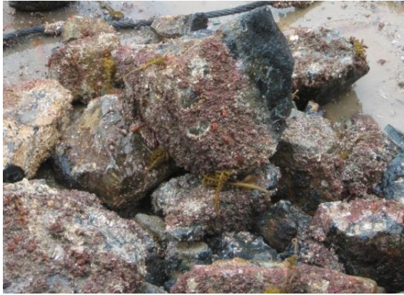
写真-1.1.3 既往の現地調査における付着物の状況（鳥取港） 1)2)
