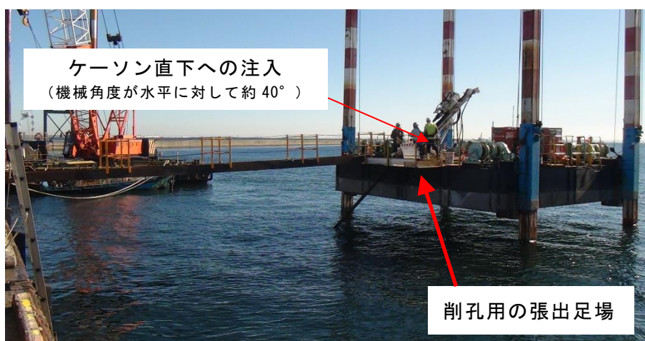
写真-5.2.3 川崎港における SEP 台船による捨石削孔状況 (ケーソン直下の場合)
