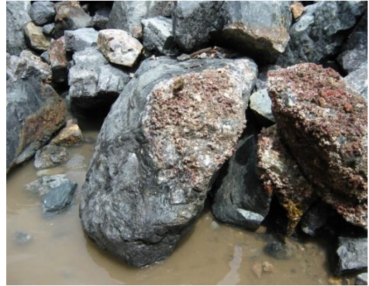
写真-1.1.3 既往の現地調査における付着物の状況（鳥取港） 1)2)
