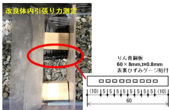
参考写真-6.2 りん青銅板の設置状況
