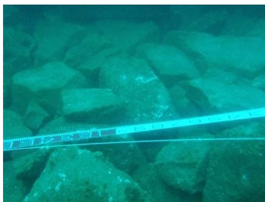
写真-2.2.1 捨石マウンド表面調査の例 1)
