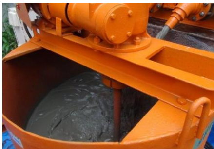
(a) 基材練混ぜ状況
