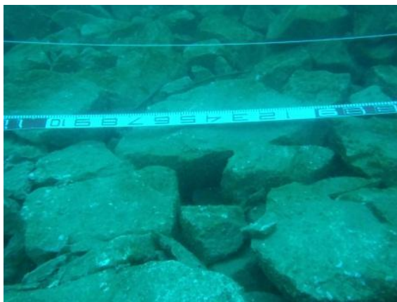
(c) 防波堤 (東第一) (高知港)
