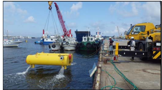
図-5 仙台塩釜港での施工状況
