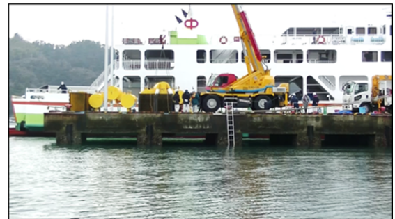
図-6 中島港での施工状況
