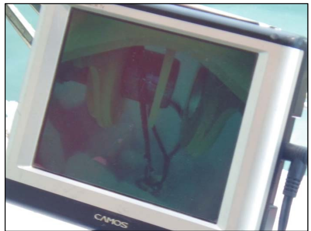
図-5 モニターで水中の玉外し状況を確認
