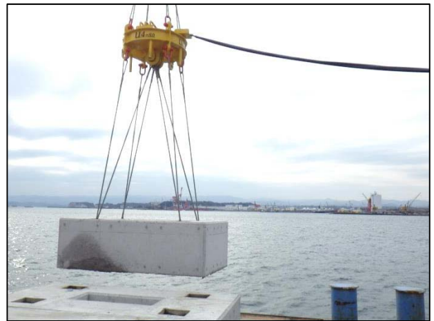
図-3 4点吊りの施工状況
